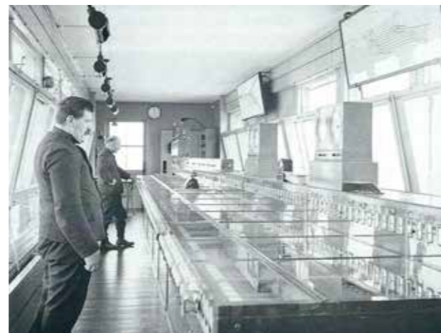
Einreihen-Stellwerk der Bauart Siemens&Halske 1912. 29.4.1938
