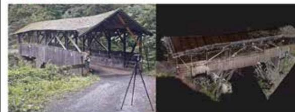
Vermessung mittels 3D-Laserscanning zur Schaffung von Planungsgrundlagen für Sanierungen und Strukturerehalt.
